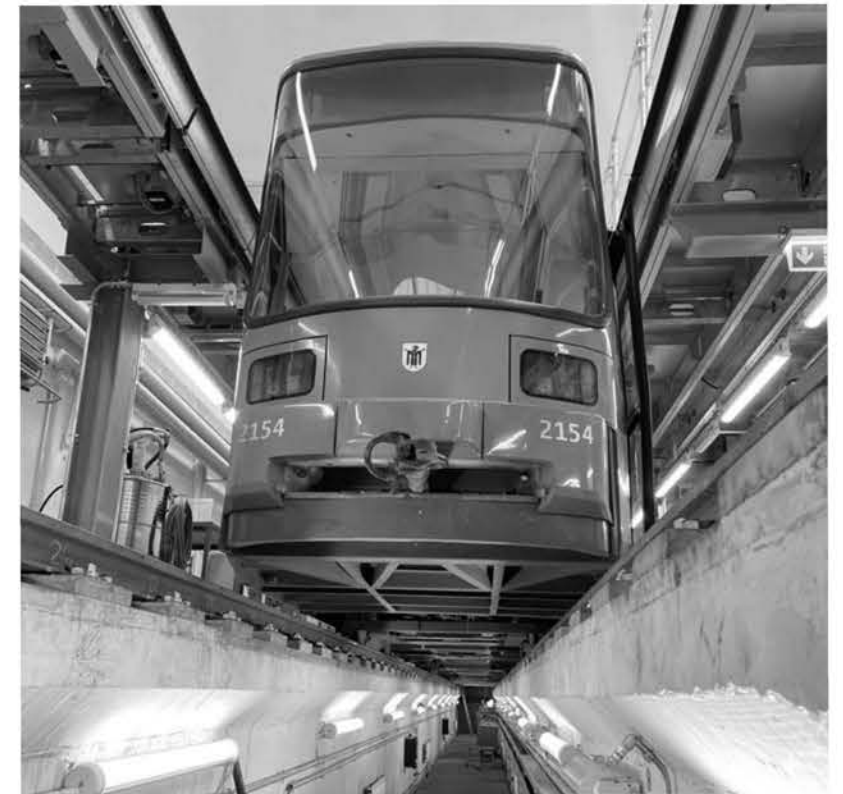
Durchleuchtung von oben und unten: Das Heck dieses Triebwagens der Baureihe R (Baujahr 1996) wird von allen Seiten her, von der Hebebühne, ebenerdig und aus der Grube, auf seine Betriebstauglichkeit hin untersucht. In München ist Vandalismus – eine weitere Ursache für Beschädigungen – im Vergleich mit anderen deutschen Städten relativ gering. Foto: Arno Unkrig.
