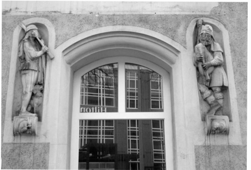
Wo sind die beiden Musikanten anzutreffen? Auflösung des Suchbilds vom vergangenen Monat: Stadtauswärts in der Rosenheimer Straße sind linkerhand zwei massive, senkrecht stehende Betonstützen der Eisenbahnbrücke aufwändig begrünt. Hoffentlich wird uns im Sommer was blühen.
