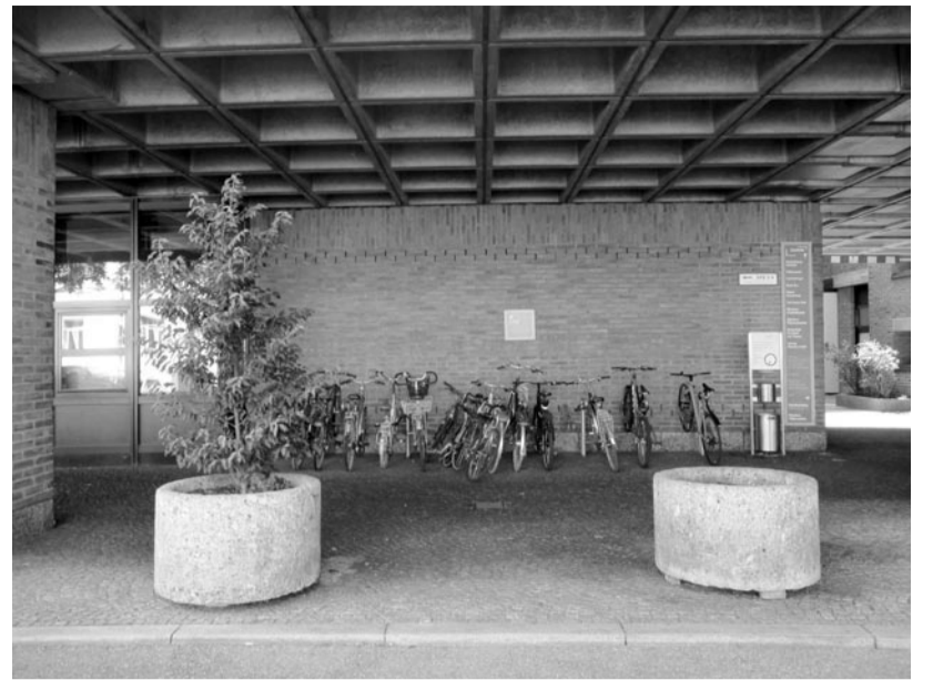
Zugang zum ehemaligen Gasteig von der Kellerstraße: Da ist noch Platz für eine Fahrradabstellanlage.
