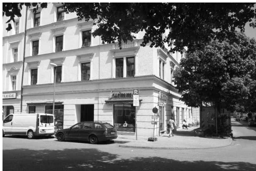
Am Pariser Platz: Der Umbau der Bäckerei hat schon begonnen.
