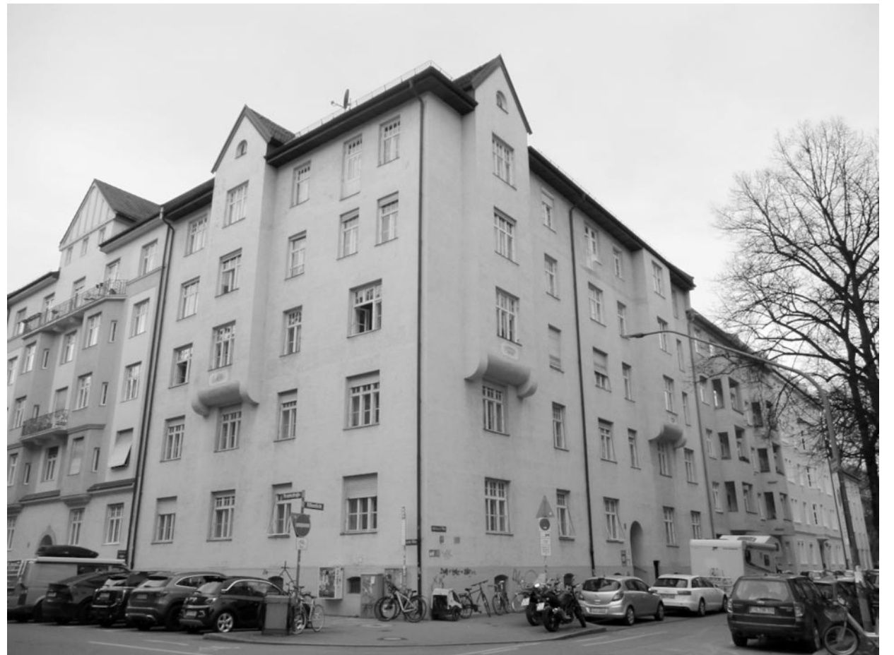
Umbauten im Haus Albanistraße 6: Geplant ist ein Dachausbau mit einer 199 m 2 - und einer 109 m 2 großen Wohnung. Der Bezirksausschuss lehnt die Planung ab. Die 199 m 2 große Wohnung führt zu einer weiteren Aufwertung des Stadtquartiers im Erhaltungssatzungsgebiet Untere Au.
