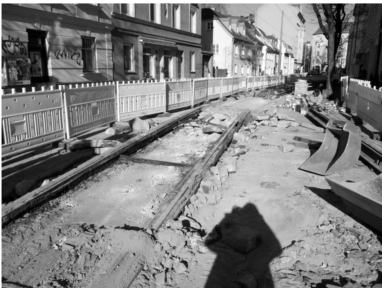
Gleiserneuerungen in der Milchstraße führen zu erheblichen Verkehrsbehinderungen.
