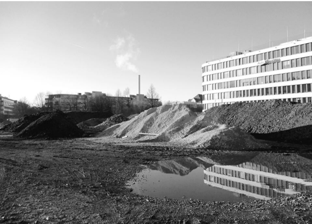
Bauplatz für das neue HVB-Gebäude
