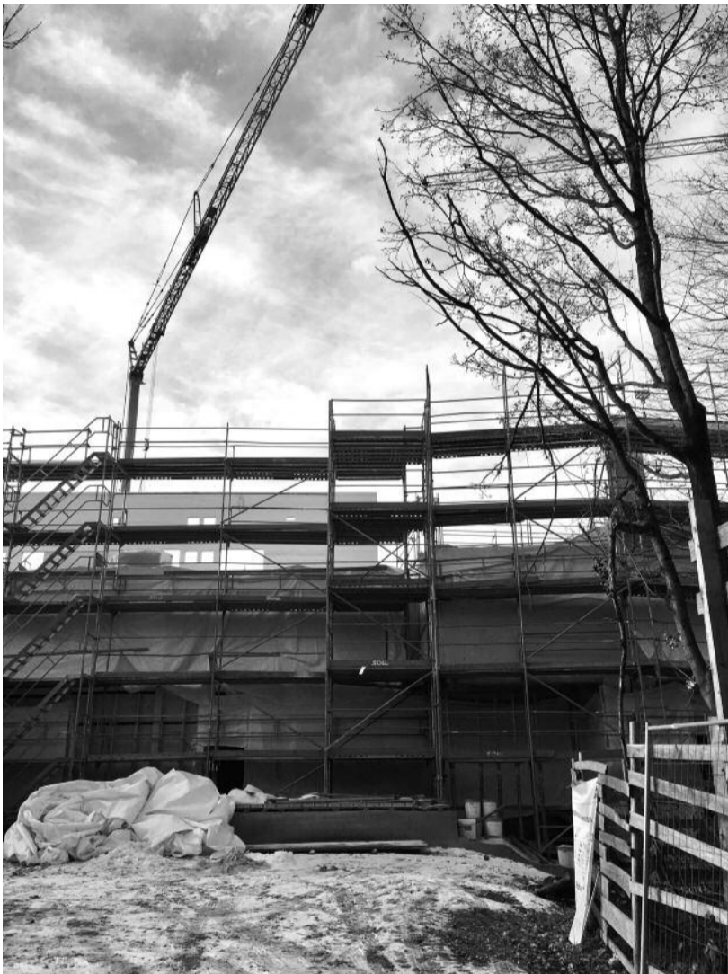
Neubau der Franziskus-Grundschule auf dem Bildungscampus an der oberen Preysingstraße
