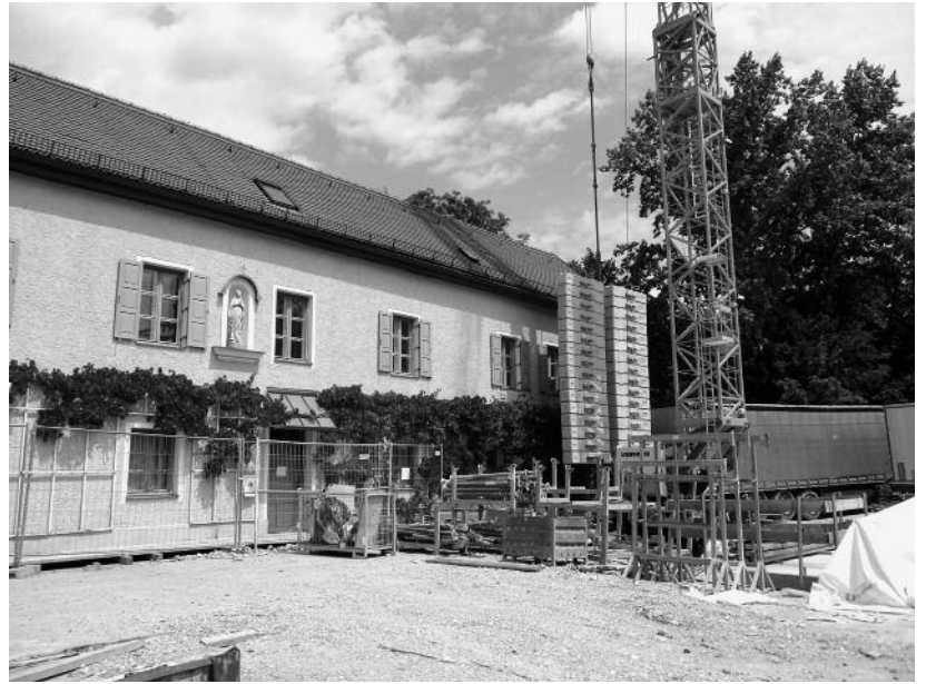
Bauarbeiten rücken dem „Schutzengelhaus“ dicht auf die Pelle.
