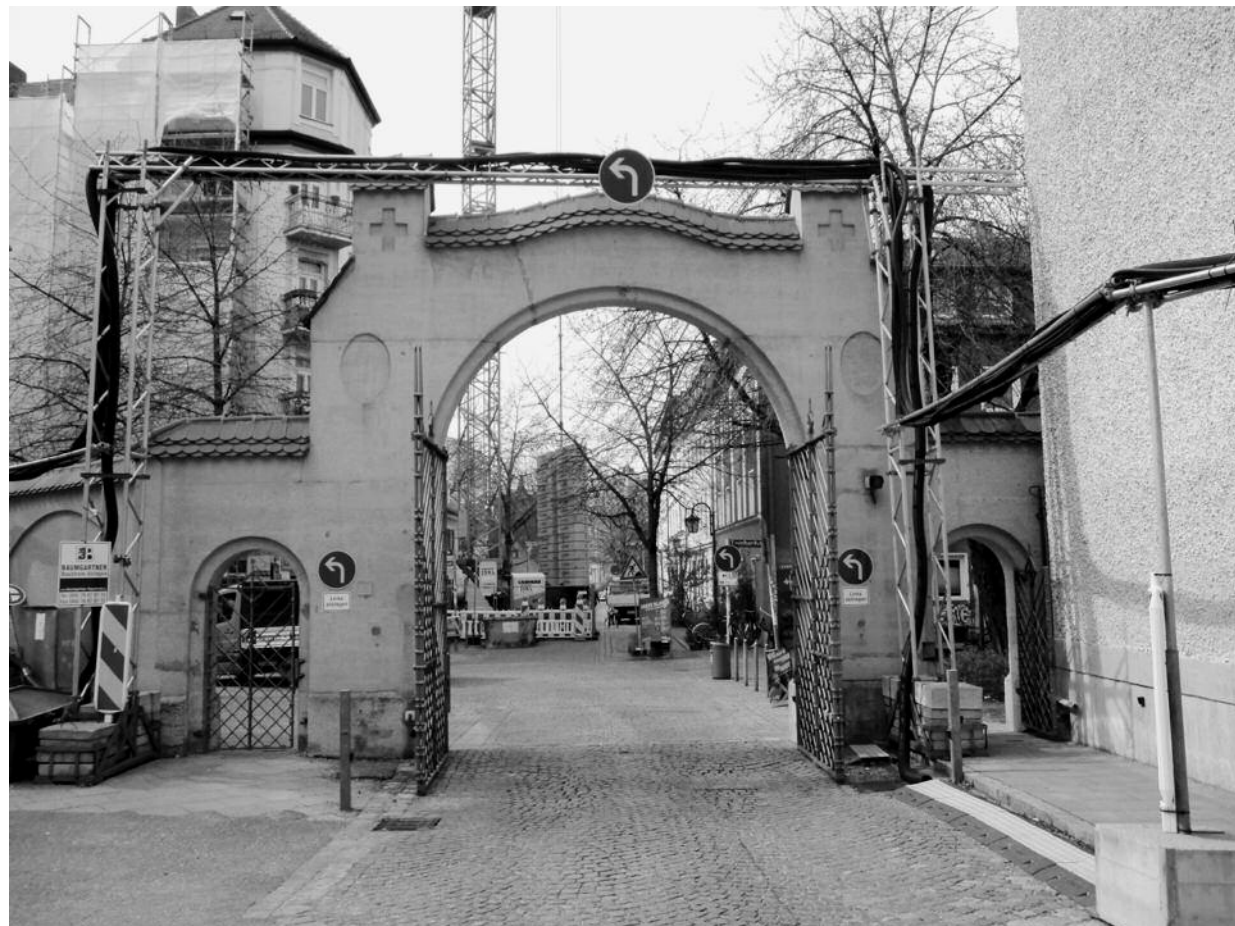
Unmissverständliche Abbiege- Aufforderung an der Ausfahrt vom Kirchlichen Gelände. Ein Baukran in der Preysingstraße tut ein übriges und blockiert die Geradeausfahrt für schwere Bau- und Lieferfahrzeuge.
