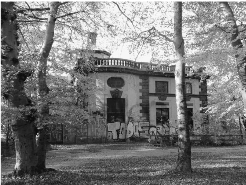
Maxwerk: Die Stadtwerke München (SWM) kommen ihrer Instandhaltungspflicht als Eigentümerin des Gebäudes nicht nach. Der Verfall schreitet voran. Wie lange kommen die Stadtwerke damit durch?
