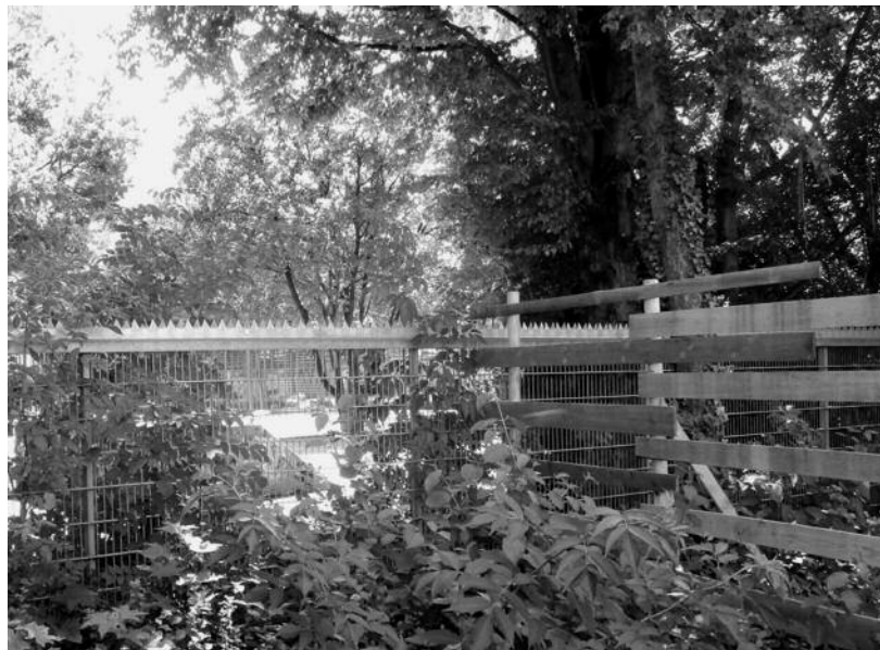
Der Baugrund der neuen Grundschule ist abgesteckt
