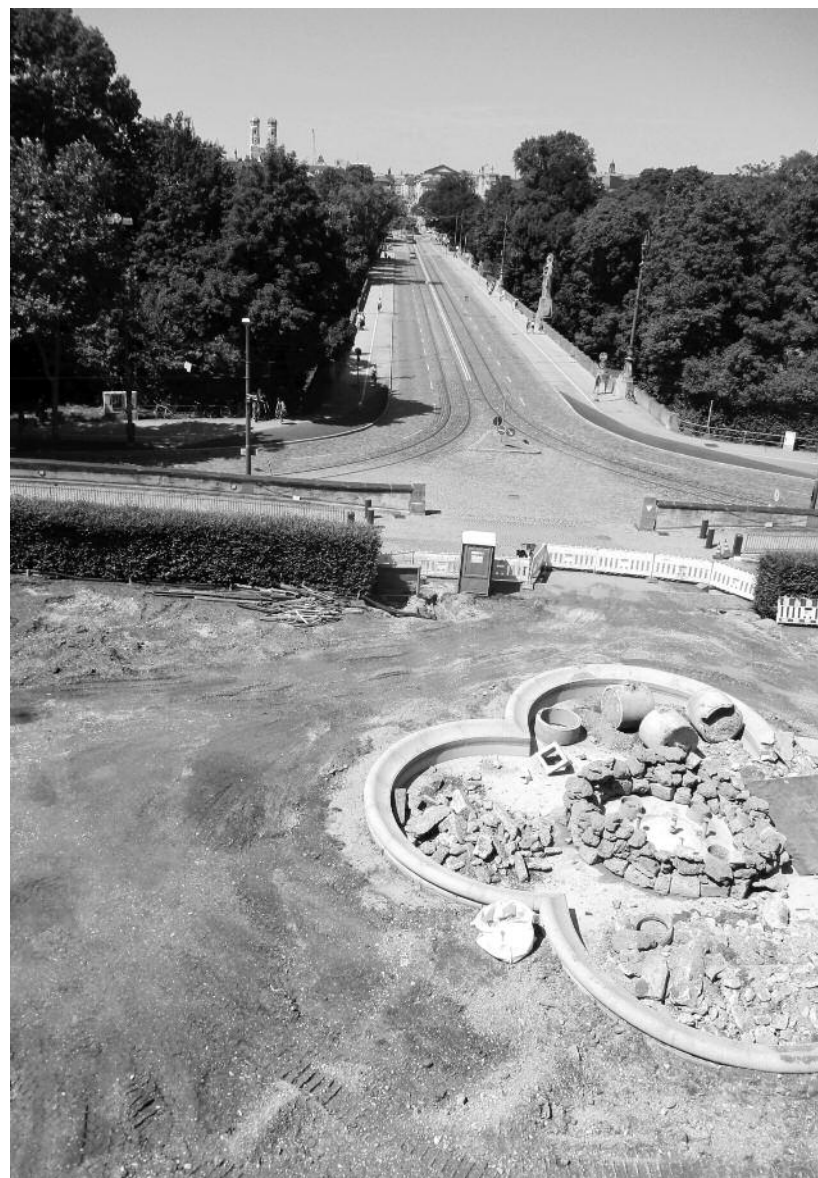
Baustelle vor dem Maximilianeum – sind dies bereits Vorbereitungen für die Verlegung des Besuchereingangs von Ost nach West?
