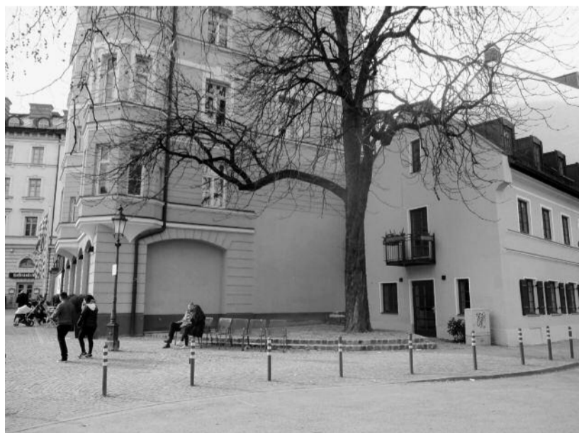
Schwarzbaubalkon am Haus Grütznerstraße 8
