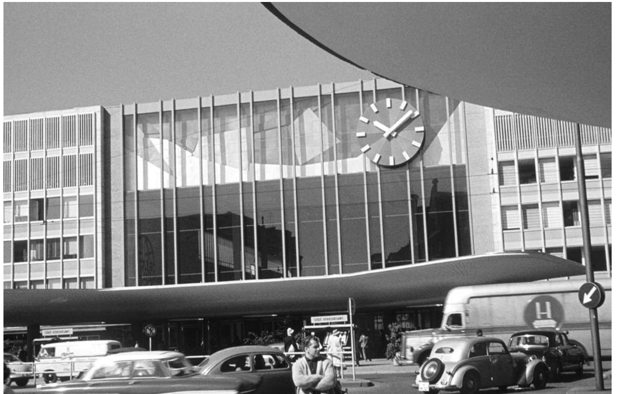
Empfangsgebäude München Hauptbahnhof – Plattenmosaik von Rupprecht Geiger (1951) im Jahr 1960 © Bildarchiv S. Winkler-München
