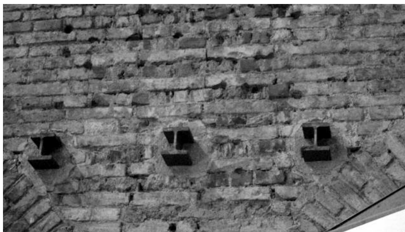
Denkmalpflege in der Empfangshalle – Ziegelrelikte aus der Bürklein-Ära
