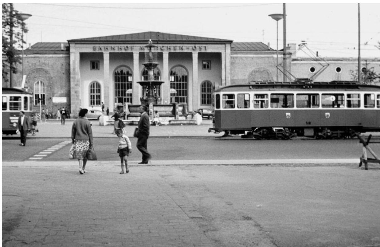
München in der Nachkriegszeit – Der Orleansplatz mit dem Ostbahnhof um 1955 © Bildarchiv S. Winkler-München. Anfang der 60er Jahre wird der Hauptbahnhof neu gestaltet. Bald ist er Geschichte. Der Umbau steht bevor (S. 6 und 7).
