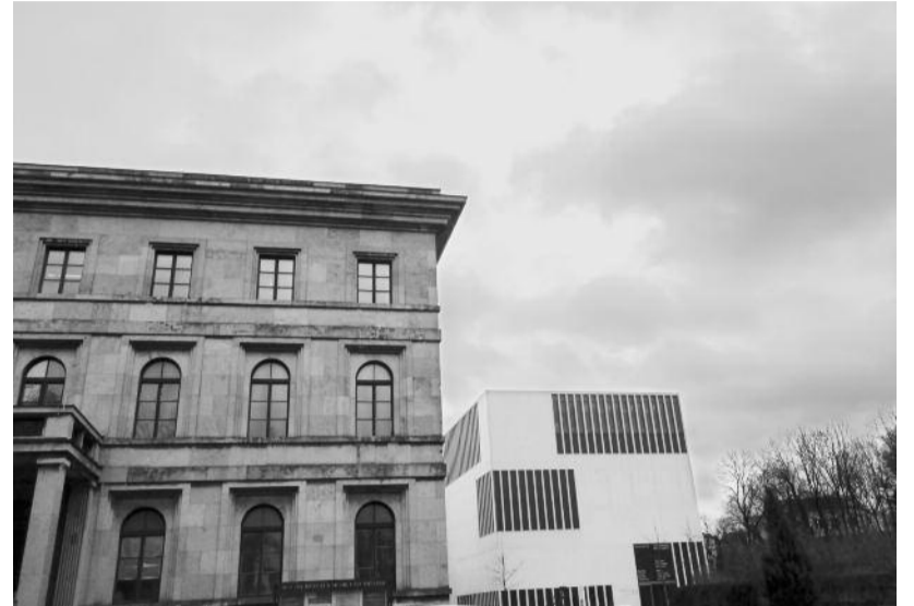
„Führerbau“ und NS-Dokumentationszentrum
