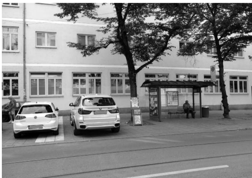
Tramhaltestelle Würthstr. mit Taststreifen für Sehbehinderte - häufig als Autoparkplatz zweckentfremdet. Die Münchner Verkehrsgesellschaft bedauert dies, ist jedoch nicht gewillt, im Interesse ihrer Fahrgäste für Abhilfe zu sorgen.
