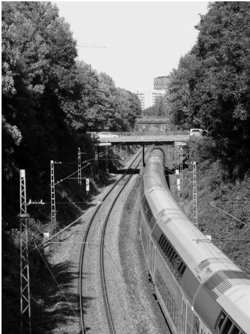
Eisenbahnsüdring Nähe Ostfriedhof
