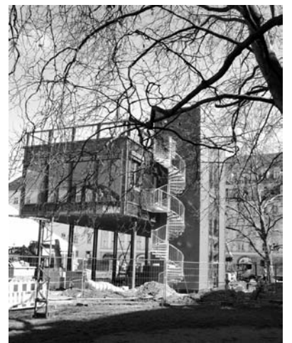
Nicht kleckern: Der DB-Informationspavillon zur 2. S-Bahn-Stammstrecke hinter dem Rathaus
