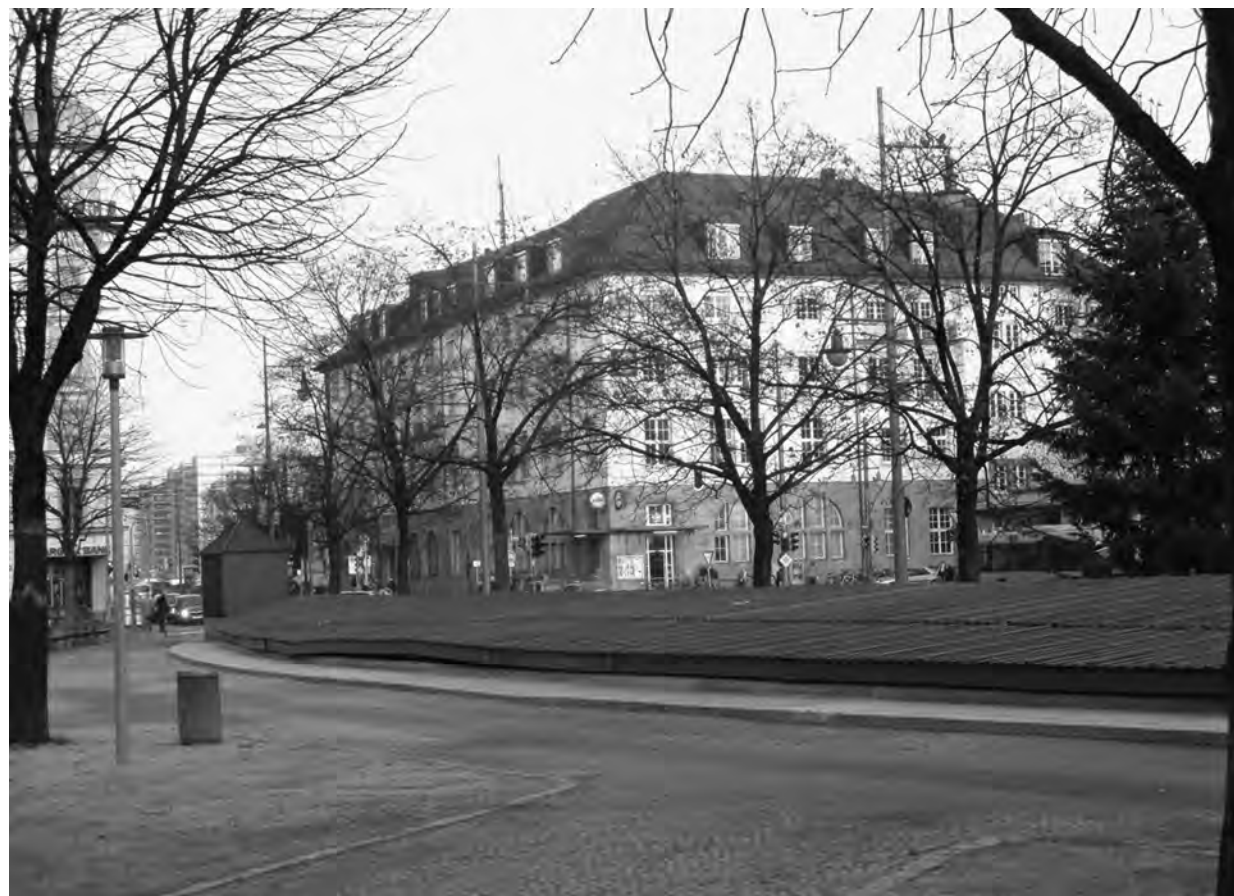
Brunnenanlage auf dem Orleansplatz: Eingemottet für nächste Jahrzehnt?
