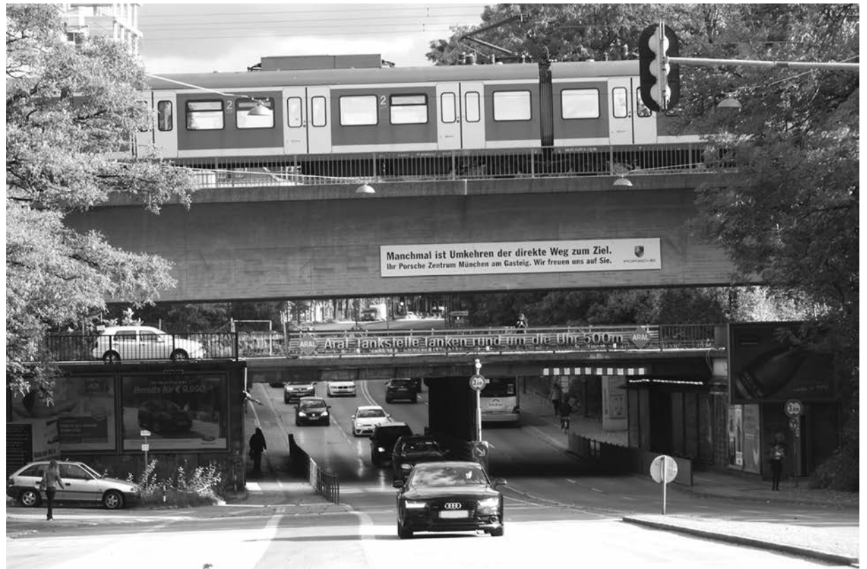
Eisenbahnbrücke Rosenheimer Straße
