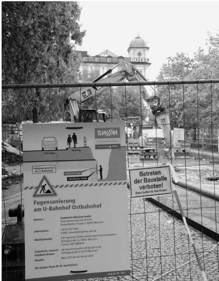
Noch bis in den Herbst 2016 werden die umfangreichen Bauarbeiten am Orleansplatz andauern. Dort wird gerade die gesamte Deckenkonstruktion der U-Bahn-Station erneuert, die durch versickertes Streusalzwasser Schaden genommen hat. Im weiteren Verlauf der Arbeiten werden auch die Fahrspuren vor dem Ostbahnhof verschwenkt werden.
