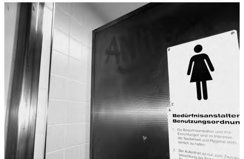
Die Toiletten im Zwischengeschloß des Rosenheimer Platzes sind von der Deutschen Bahn instandgesetzt und geöffnet worden - die Benutzung ist sogar kostenlos.
