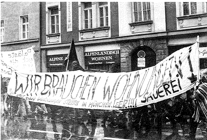
Foto: Häusernot-Demonstration „Wir brauchen Wohnungen ...“; 1979 © Archiv der Münchner Arbeiterbewegung
