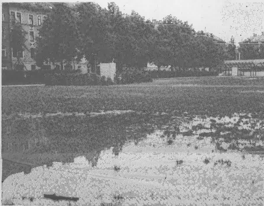
Tiefgarage Postwiese - sollte es geregnet haben??
