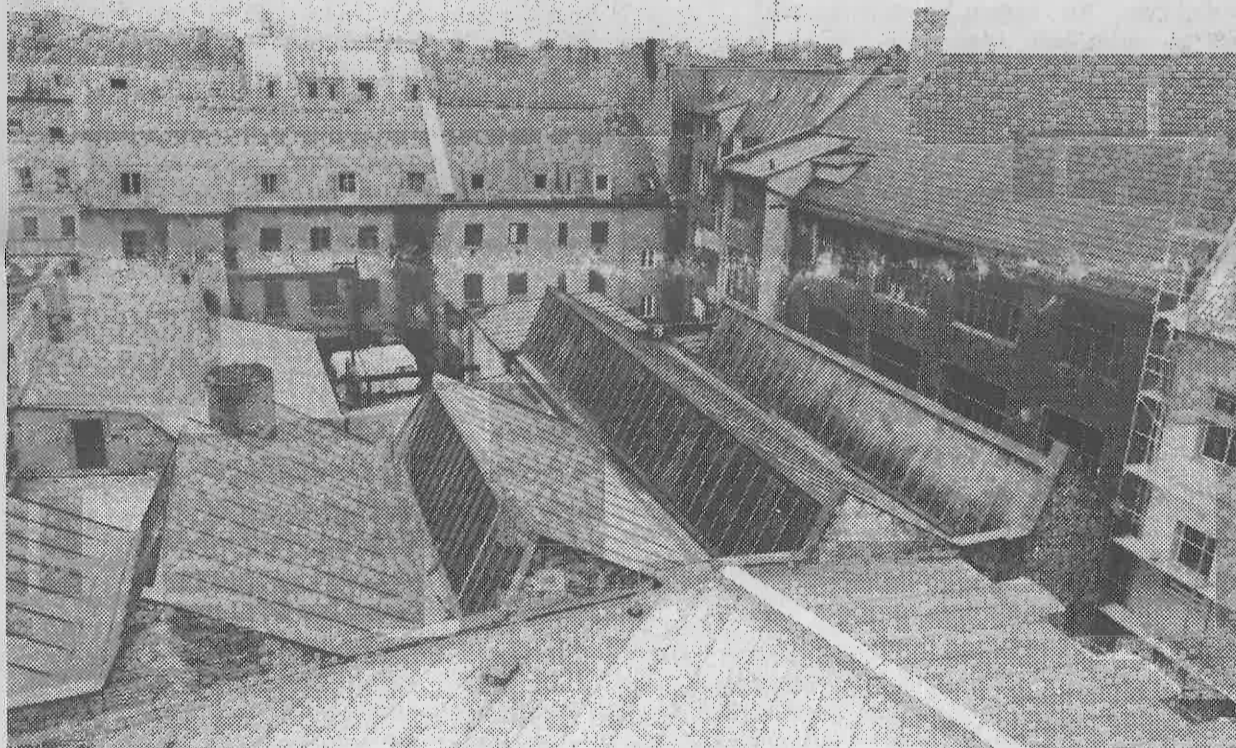
Block 8: Dichte Bebauung im Innenbereich; quer durch die Mitte die Produktionshallen der Maschinenbaufirma Schärfl.
