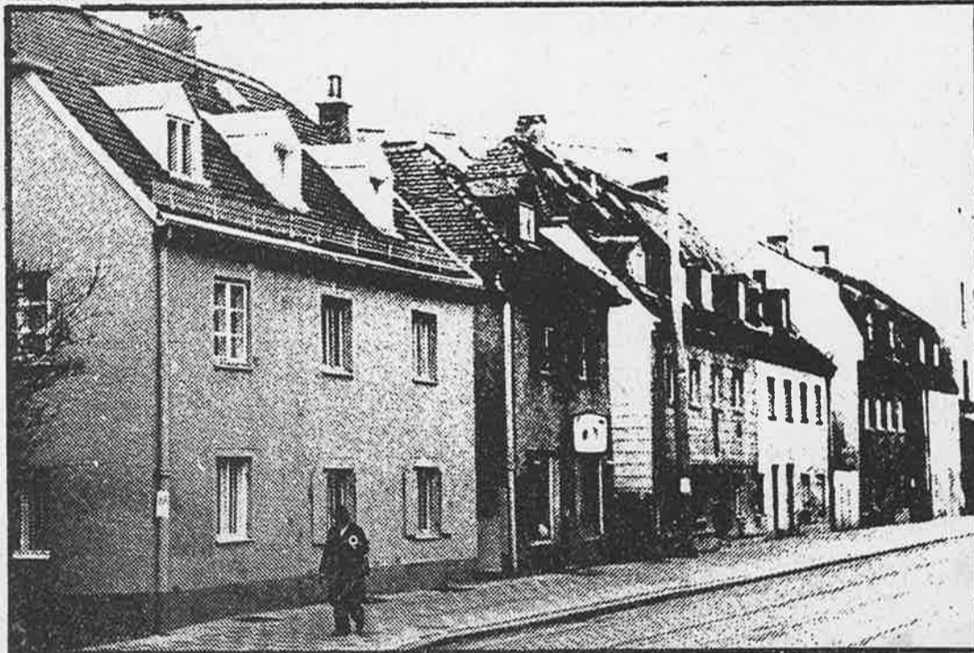
An ihrer Stelle soll eine Straßenerweiterung kommen: Häuser in der Milchstraße.
