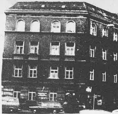
Auch dieses gut erhaltene Haus an der Milch/Steinstraße soll abgerissen werden
